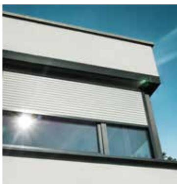
Volet roulant QUADRO monté en applique sur la façade.
